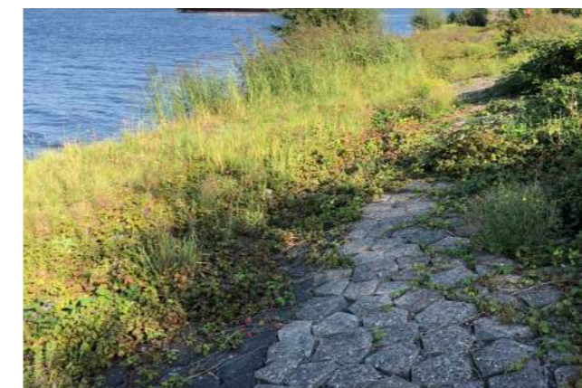
Basaltoever gemaakt van beton, basaltion (foto: Geert Timmermans)
