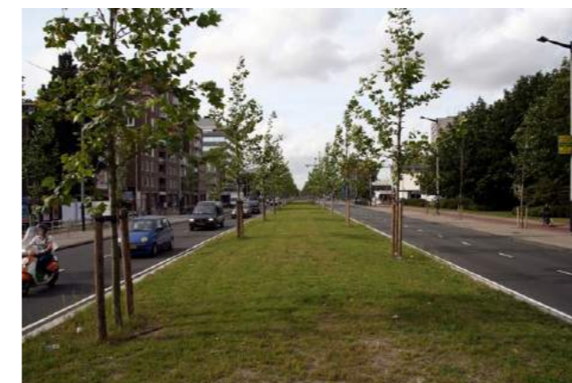
Bovengrondse verankering Wibautstraat (foto: Cécile Obertop)
