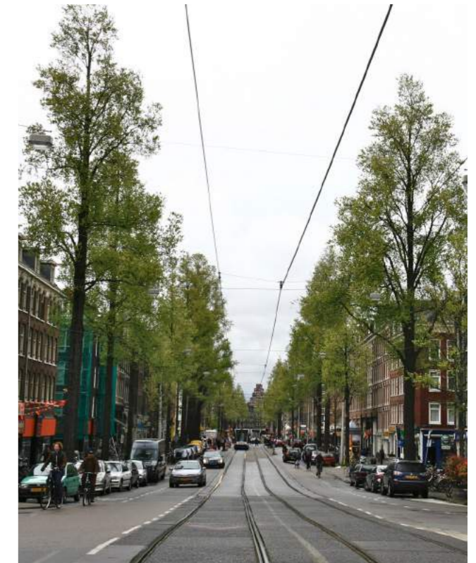
Profiel van vrije ruimte trambaan (foto: Hans Kaljee)
