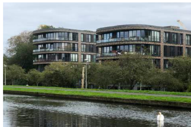
Harde oever, ter hoogte van de Ringdijk Watergraafsmeer (foto: Geert Timmermans)
