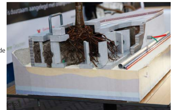
Maquette van technische constructie bij bomen langs gracht (foto: Hans Kaljee)
